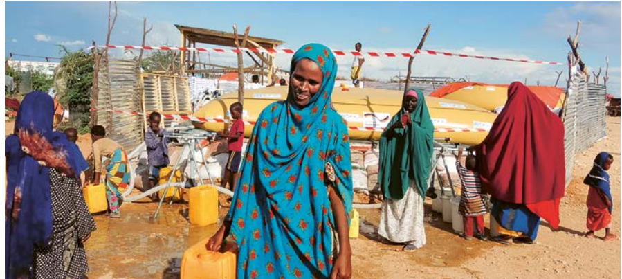
▲ Zur Hilfe gehört auch der Bau von Trinkwasseraufbereitungsanlagen wie hier in Somalia.
