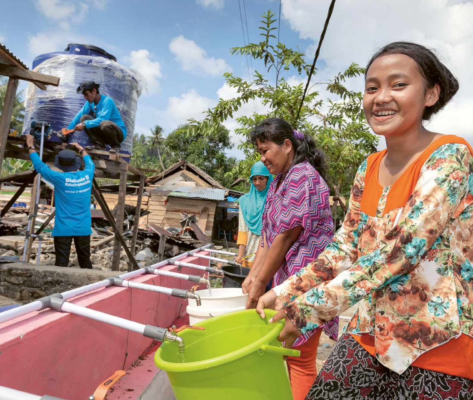
▲ Die Frauen des Dorfes Tovea in Indonesien freuen sich über sauberes Wasser. Im Hintergrund arbeiten SHEEP-Mitarbeiter an der Befestigung der Installationen. Nach Erdbeben und Tsunami war die Wasserversorgung zerstört.
