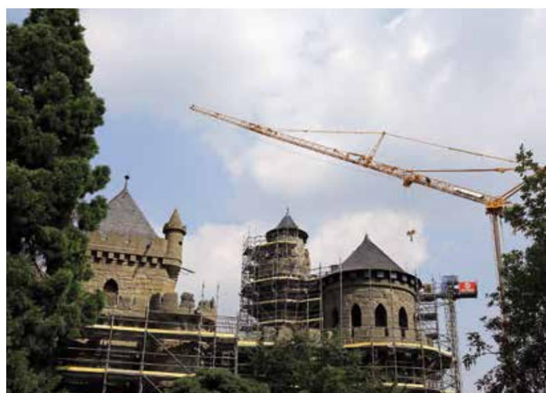
Zurzeit eine Baustelle: die Löwenburg im Bergpark Wilhelmshöhe
