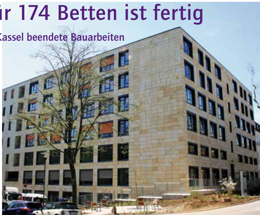
Der Neubau steht: Blick auf den Bettentrakt an der Kreuzung Goethestraße/Kirchweg. Unten ein Bild vom Abriss des Altbaus
